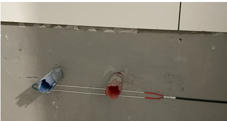
Линейный датчик **KapleStop KS-B500** обнаружения воды в бетоне, плиточном клее
