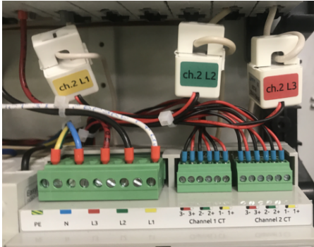
Подключение ТОКОВЫХ трансформаторов
